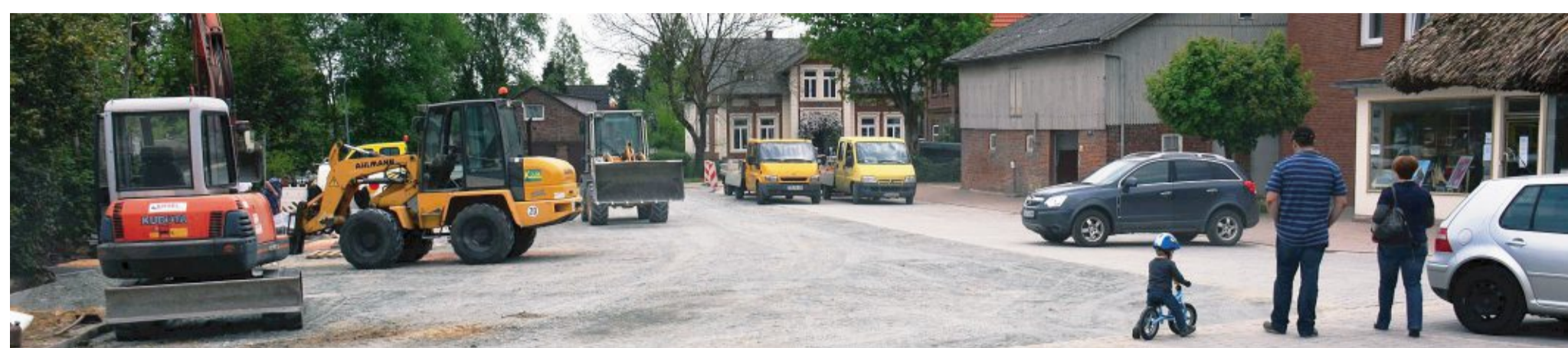
Nur drei Monate werden die Bauarbeiten am Ostener Fährplatz dauern. Der Einweihungstermin am 1. Juni ist nicht gefährdet.
